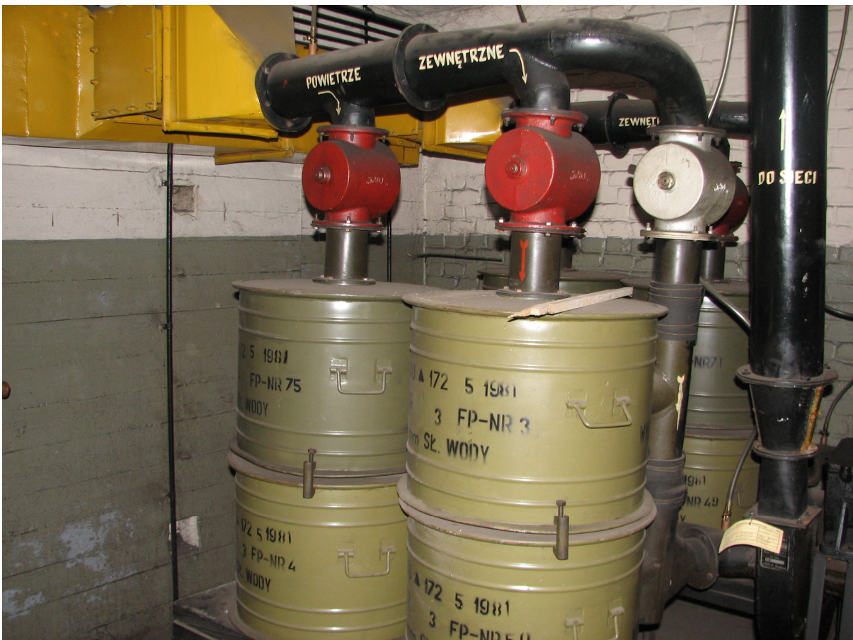
Filtropochłaniacze FP-100, oczyszczające powietrze z pyłu radioaktywnego oraz substancji toksycznych
