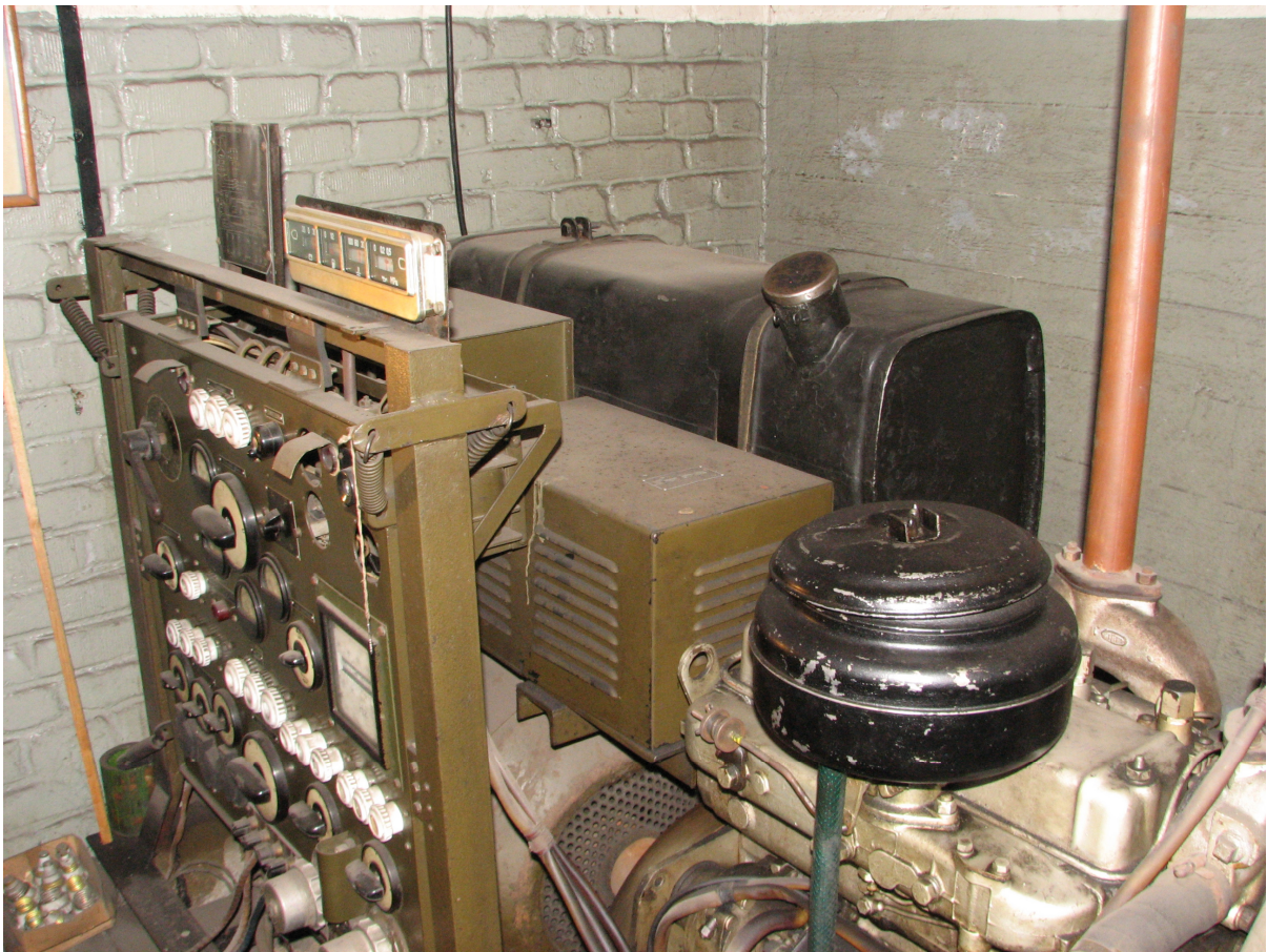
Generatory prądu (sprawne)
