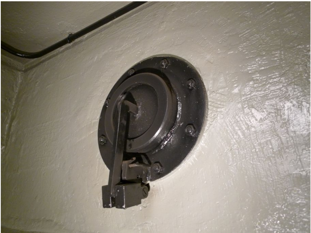
Automatycznie otwierana wywiewna kłapa schronowa WKS-150, wypuszczająca zużyte powietrze na zewnątrz schronu
